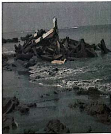
Foto No. Ejemplo de destrucción.
