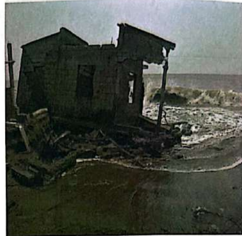
Foto No. Ejemplo de destrucción producida
