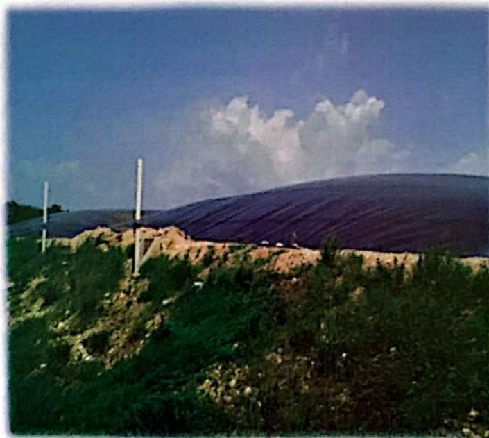
Figura 9. Biodigestores que utilizara PALMASA para la generación de energía eléctrica.
