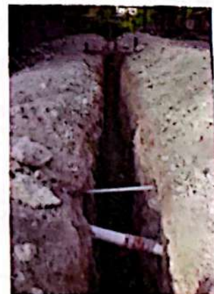
Alcantarillado en construcción. La Campa
